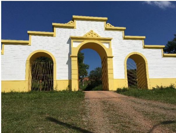
FIGURA 86 – ACESSO 02 FONTE: ACERVO DO AUTOR, 2022
