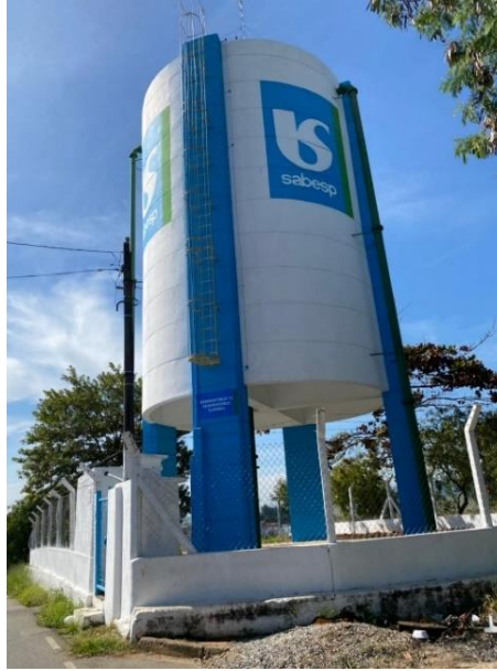
FIGURA 156 – RESERVATÓRIO DE ÁGUA TRATADA FONTE: ACERVO DO AUTOR, 2022
