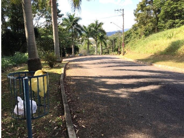
FIGURA 121 – PAVIMENTAÇÃO – VISTA 01 FONTE: ACERVO DO AUTOR, 2022
