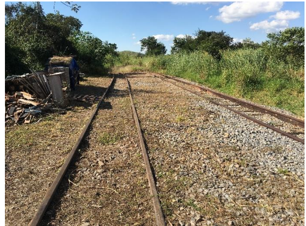
FIGURA 152 – DISPOSIÇÃO INADEQUADA DE RESÍDUOS DA CONSTRUÇÃO CIVIL FONTE: ACERVO DO AUTOR, 2022
