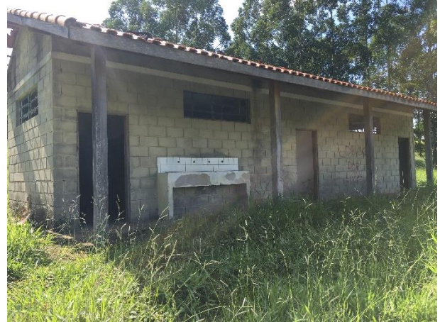
FIGURA 139 – SANITÁRIO 04 FONTE: ACERVO DO AUTOR, 2022
