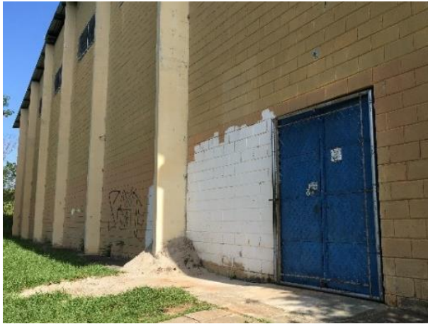
FIGURA 99 – QUADRA – VISTA EXTERNA FONTE: ACERVO DO AUTOR, 2022
