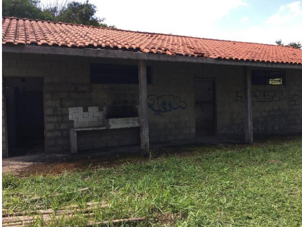
FIGURA 138 – SANITÁRIO 03 FONTE: ACERVO DO AUTOR, 2022
