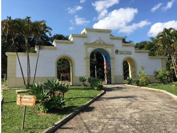
FIGURA 84 – ACESSO 01 FONTE: ACERVO DO AUTOR, 2022
