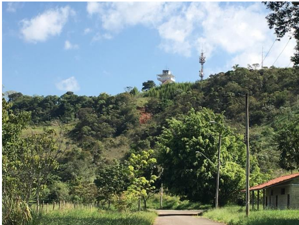
FIGURA 35 – EROSÃO – VISTA 01 FONTE: ACERVO DO AUTOR, 2022
