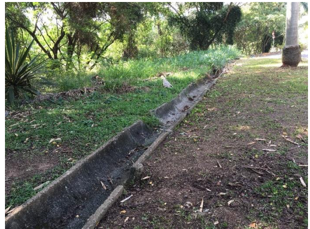
FIGURA 124 – VALA DE DRENAGEM FONTE: ACERVO DO AUTOR, 2022
