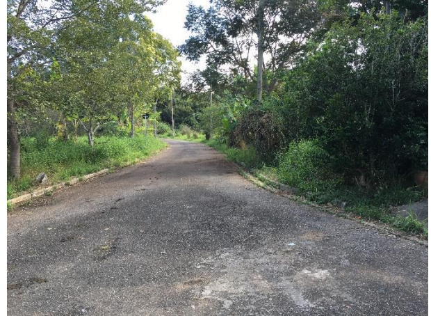
FIGURA 122 – PAVIMENTAÇÃO – VISTA 02 FONTE: ACERVO DO AUTOR, 2022
