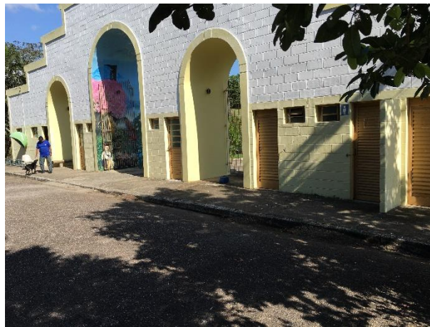
FIGURA 140 – SANITÁRIO DO PORTAL FONTE: ACERVO DO AUTOR, 2022
