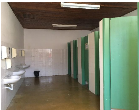
FIGURA 136 – SANITÁRIO 01 FONTE: ACERVO DO AUTOR, 2022
