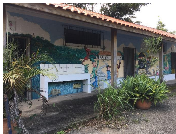
FIGURA 137 – SANITÁRIO 02 FONTE: ACERVO DO AUTOR, 2022
